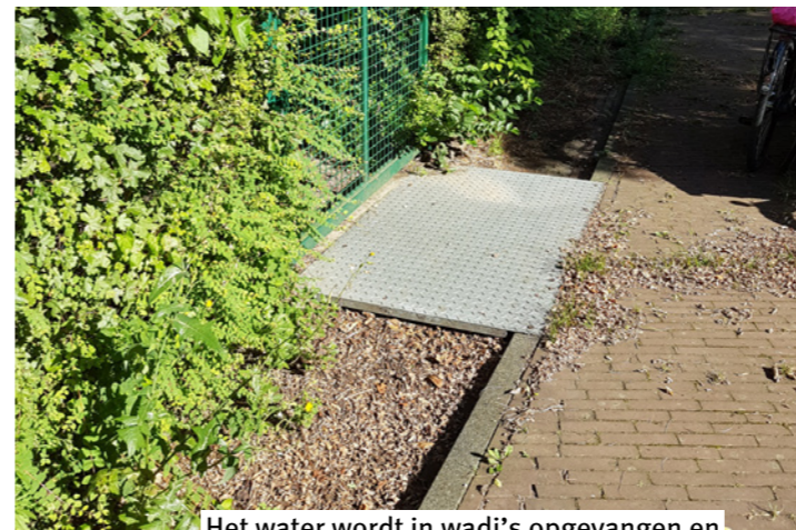
Het water wordt in wadi's opgevangen en naar de vijver geleid
