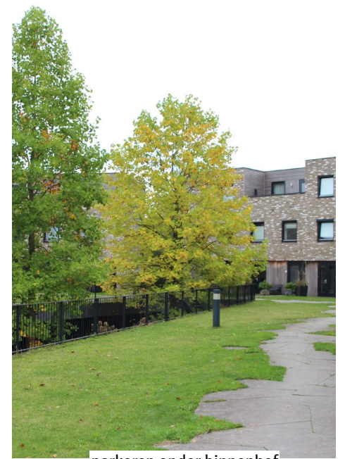
parkeren onder binnenhof
