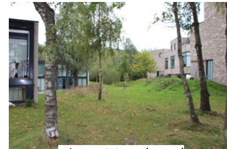
ruig gras tot aan de gevel
