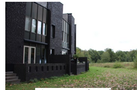
ruig gras tot aan de gevel
