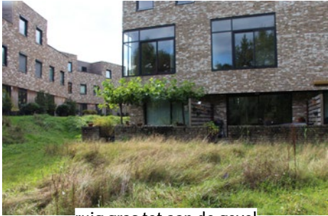
ruig gras tot aan de gevel
