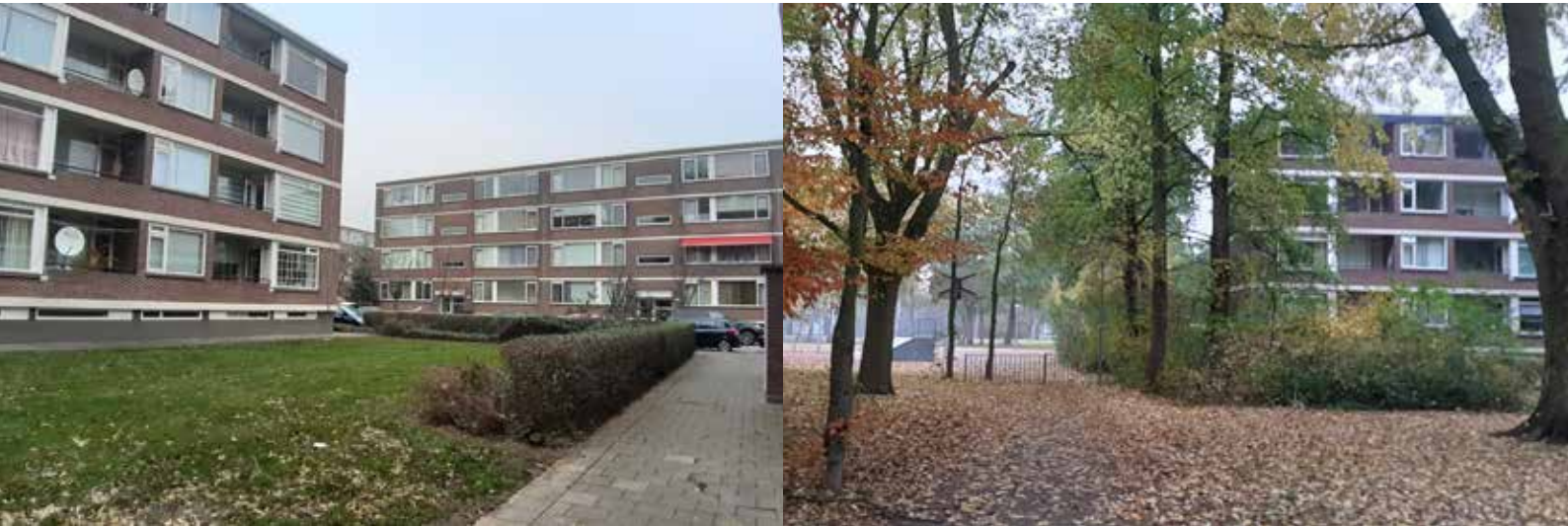
Impressiebeelden Reyeroord. (Fotograaf: Nanda Sweres)
