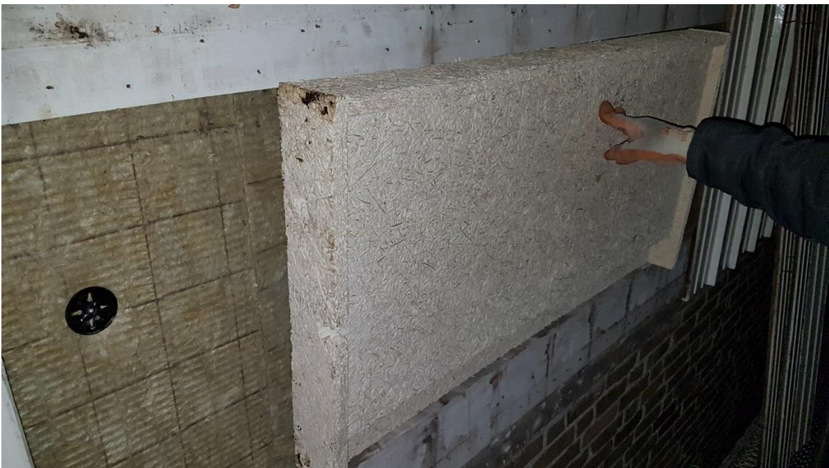
Vleermuisverblijf achter houten betimmering, Breekkers te Son, Woonbedrijf Eindhoven. Bron: Arcadis.
