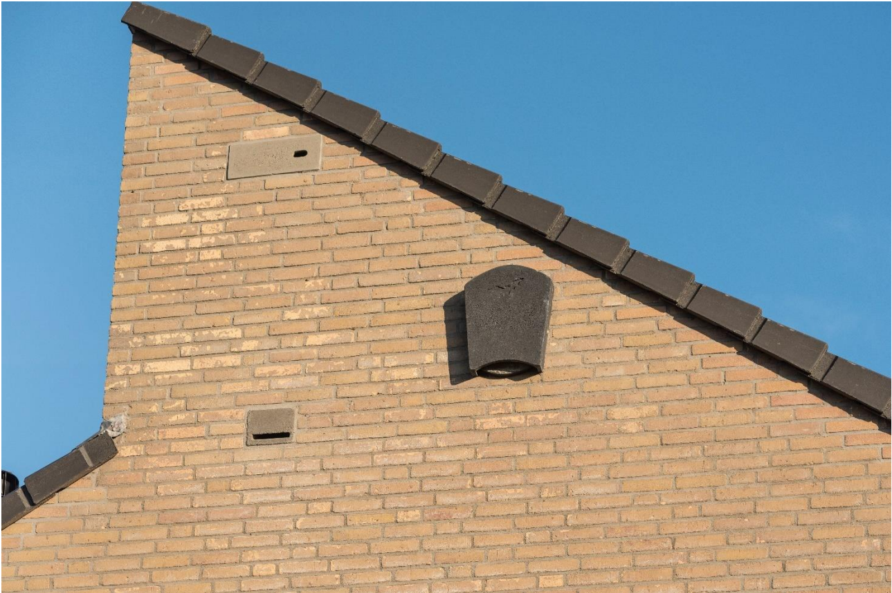
Entreesteen ingebouwd (links onder) in combinatie met een inbouwkast gierwaluw en een opbouw vleermuiskast (tijdelijke mitigatie) (Bron: Vivara Pro)
