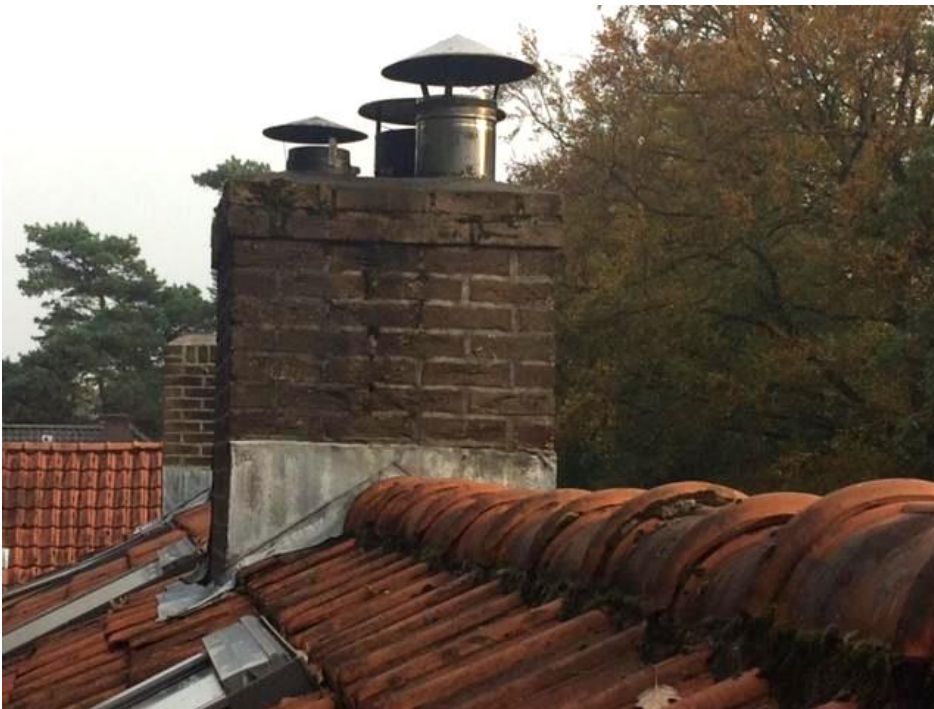
Voorbeeld schoorsteen met loodslab. Bron Werkspot.nl.
