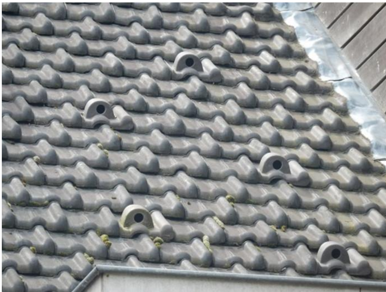
Voorbeeld van mussenpannen op een pannendak (Bron: Brabants Dagblad).
