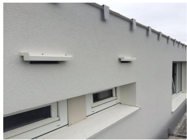
Voorbeeld vleermuisverblijf in de voorgevel. (Let op dat er voldoende ruimte is tussen dak en uitvliegopening in verband met predatie vanaf het dak) Bron: Arcadis.
