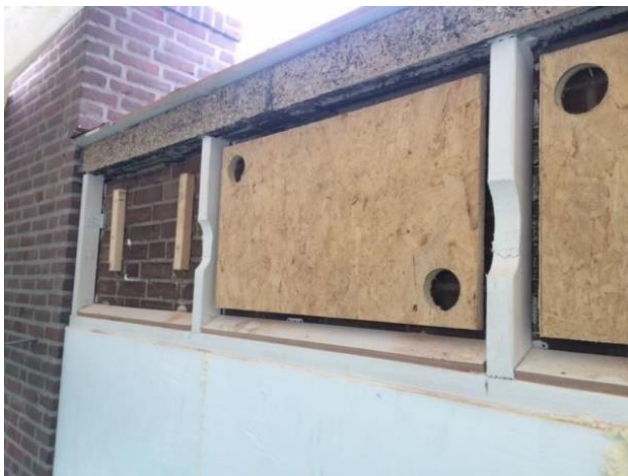
Voorbeeld vleermuisverblijf in de voorgevel. (Let op dat er voldoende ruimte is tussen dak en uitvliegopening in verband met predatie vanaf het dak) Bron: Arcadis.
