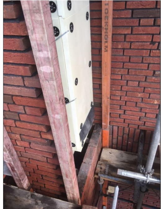
Uitvoeringsvoorbeeld project met foto's van de vloermuiskast ten behoeve van massa-winterverblijf. Platen hier zijn opgeruwd met tegellijm zodat vloermuizen grip kunnen krijgen. Bron: Arcadis.
