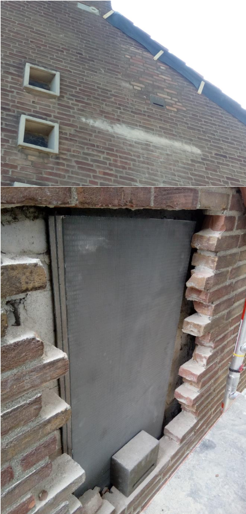
Vleermuisverblijf in gevel met inbouwmodule Miecon en entreesteen. (Bron: Arcadis).
