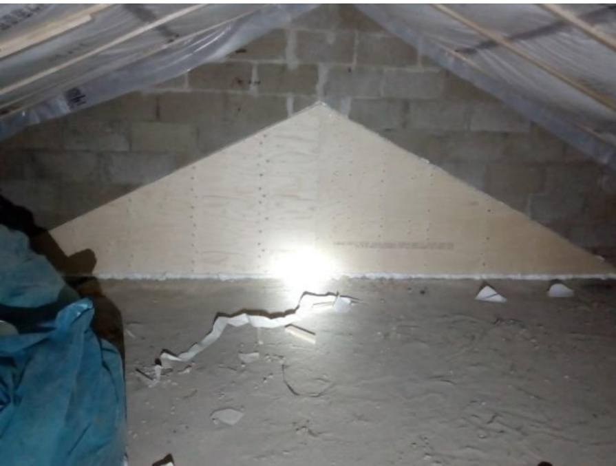
Gaten in de muur met invliegstenen (niet op de foto), een tussenschot met gaten 50 mm diameter en meerlaagse betimmeringspaneel. Alleen dakruimte is geïsoleerd, de vloer niet zodat de verblijfplaats wordt opgewarmd (gunstig). Bron: Arcadis.
