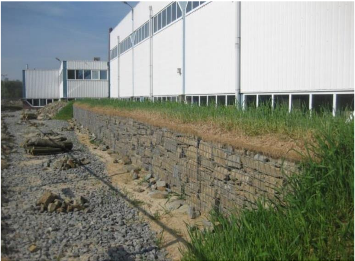
Reptielenschanskorf (ontwerp en na aanleg) als verblijfplaats voor de muurhagedis. Project Belvédère, Maastricht. Bron: Arcadis.
