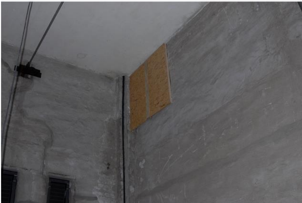
Vleermuisverblijven in zolderruimte van de Pastoor van Askerk, Woonbedrijf Eindhoven. Betreft duurzame invliegopeningen en plaatmateriaal waarachter vleermuizen kunnen verblijven. Bron: Arcadis.
