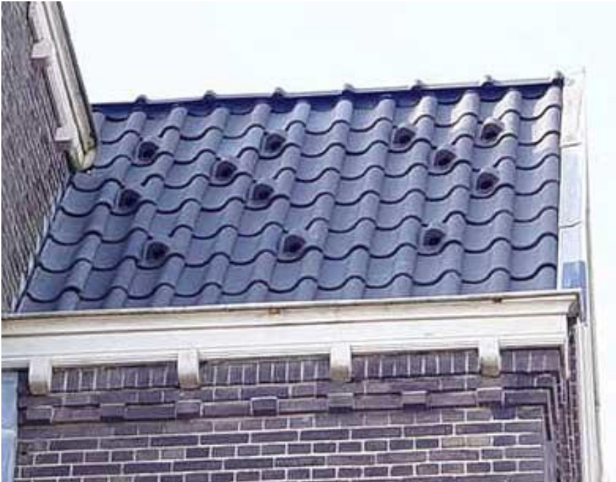
Gerenvoerd dak van de Lutherse kerk in Den Helder.
