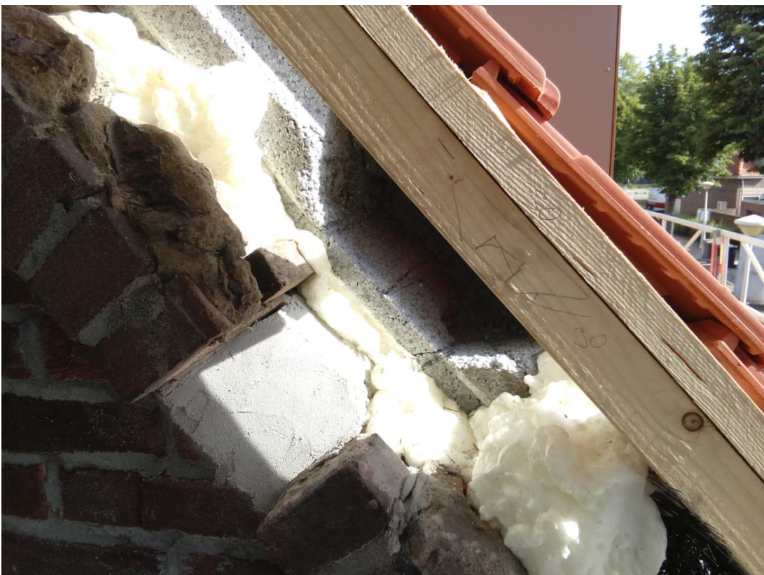
Voorbeeld gierwaluwverblijf via opening in rollaag naar ruimte onder kantpan. Bron: Arcadis.
