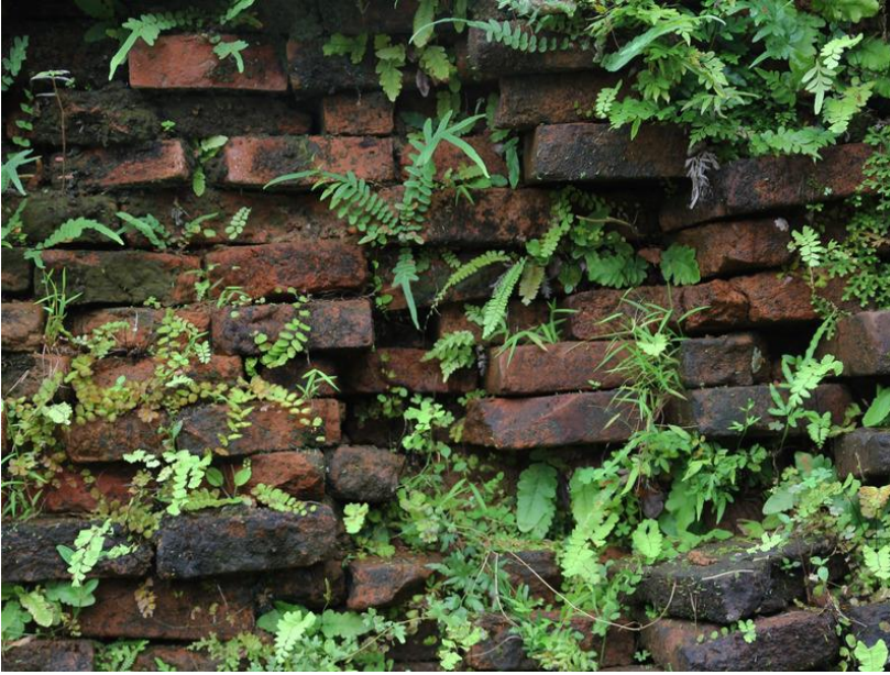
Onregelmatige muur met veldbrandstenen begroeid met varens en andere kruiden. Bron: korstmos.be.
