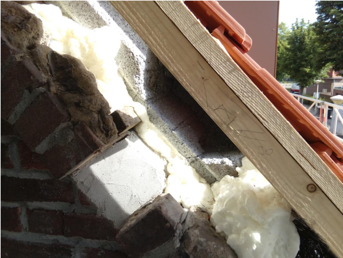
Voorbeeld gierzwaluwverblijf via opening in rollaag naar ruimte onder kantpan. Dergelijke openingen kunnen ook toegang geven naar dakruimte voor vleermuizen. Bron: Arcadis.
