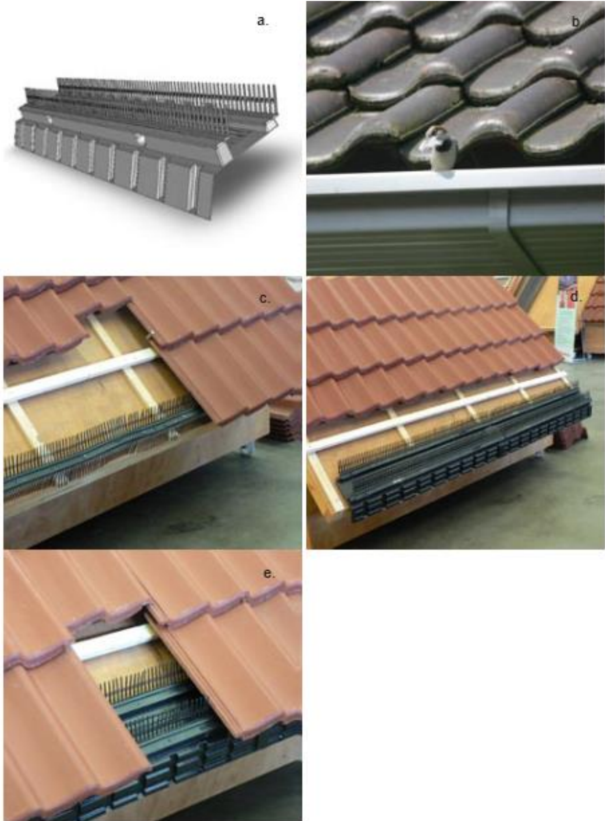
Opbouw van de vogelvide (a), dak met Monier vogelvide (b), traditioneel dak met vogelschroot (c), dakvoet met Monier vogelvide (d), dakvoet met Monier vogelvide en pannendek (e). Bron ERB-samenvatting Monier Vogelvide (2009).
