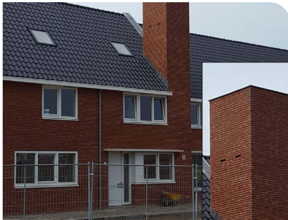
Toegankelijk gemaakte loze ruimte in sierschoorsteen.
