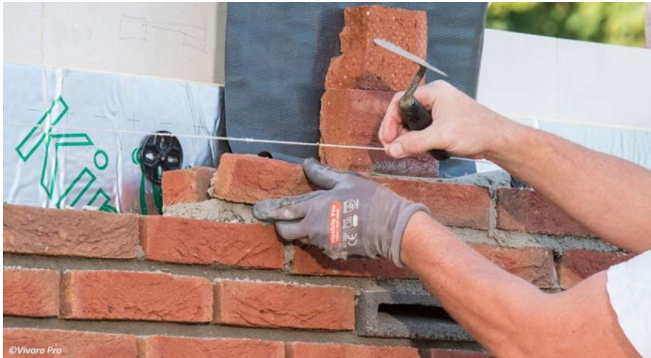
Een vogel- of vleermuiskast kan aan de voorzijde worden afgewerkt met steenstrips. Alleen de inliegopening blijft dan zichtbaar.
