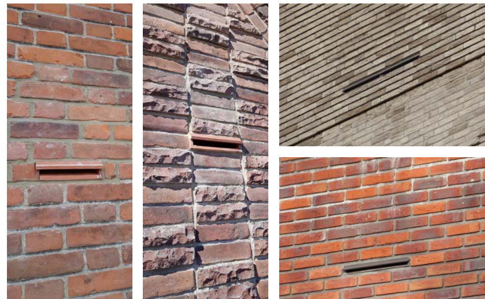
Ingemetselde Grote en Kleine Tichelaar vleermuiskasten in nieuwbouwgevels. Foto's rechts: Erik Korsten.
