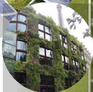
6. Groene gevel en energiedak/retentiedak
