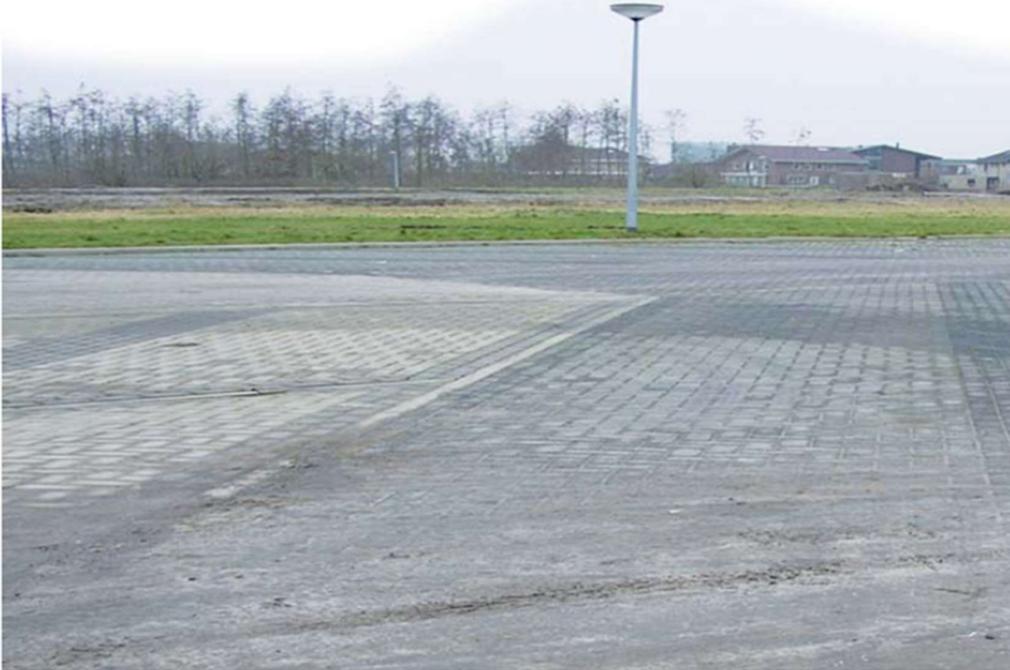
Figuur 3: Dichtgeslibde doorlatende verharding
