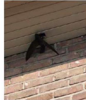
Gierzwaluwsteen weggewerkt in dakrand
