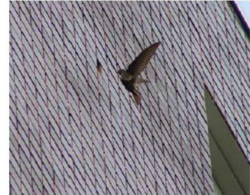
Gierzwaluwsteen weggewerkt in gevel
