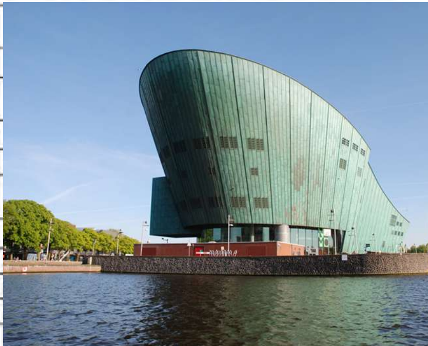
Afbeelding 5. materiaalgebruik: koperen gevel (links) en loodslabben (rechts).
