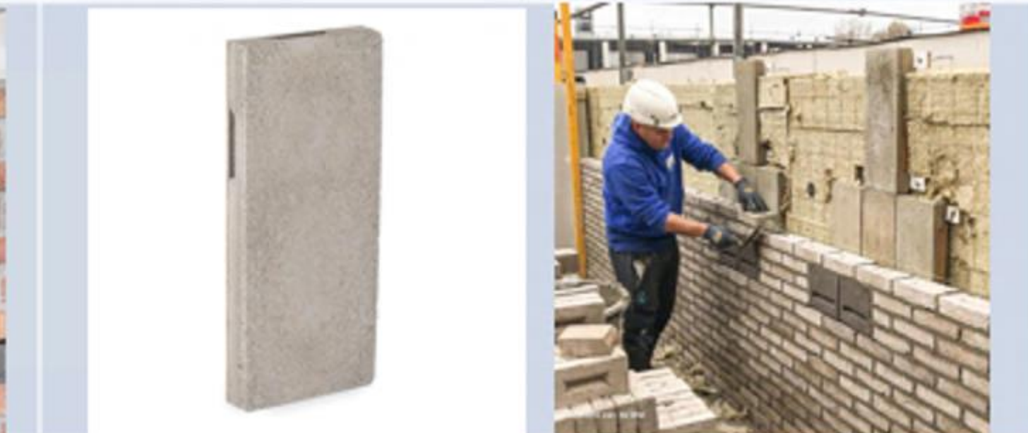
Inbouwsteen Vleermuis – enkel-laags Zichtbaarheid gevel: niet zichtbaar - in spouw
