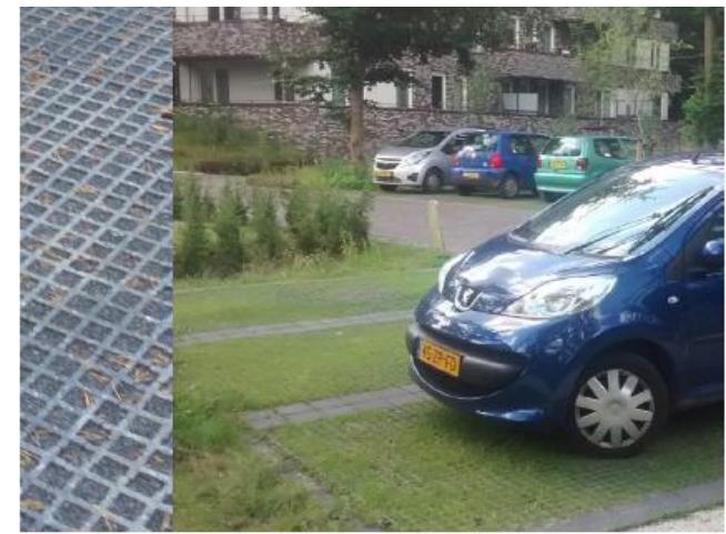
GRASBETONSTENEN Klostermann greenSTON grasbetonsteen. Zie voor verdere specificaties hoofdstuk 4 parkeren.
