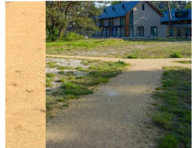
HALFVERHARDING STOL Stol, dik 0,10 m, menggranulaat dik 0,25m; sortering 0/31,5
