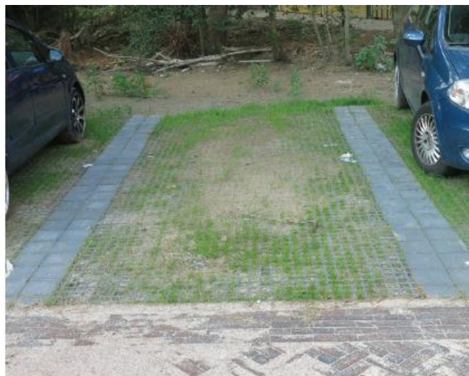
PARKEERVAKKEN MET OPEN BESTRATING T.B.V. INFILTRATIE
