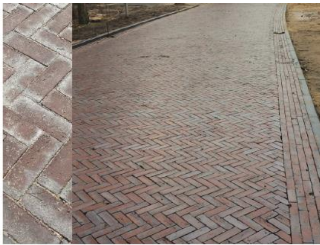
STRAATBAKSTEEN Dikformaat, Wienerberger, type: wasserstrich - kleur: juist, keperverband. Richtingverandering d.m.v. vlechtsnaad
