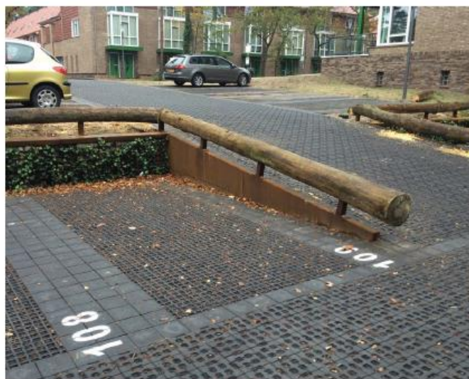
PARKEERBAK MET OPEN BESTRATING T.B.V. INFILTRATIE
